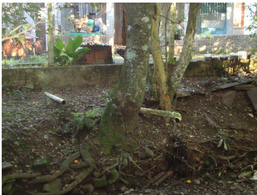
Figura 39 – Ausência de fossa e sumidouro
