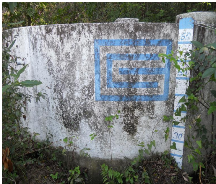
Figura 28 – Reservatório 01, 25m 3 , de concreto, apoiado, que está situado no pátio da CORSAN e que serve para a operação da ETA.
