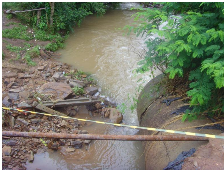
Figura 53 – Tubulação de drenagem insuficiente
