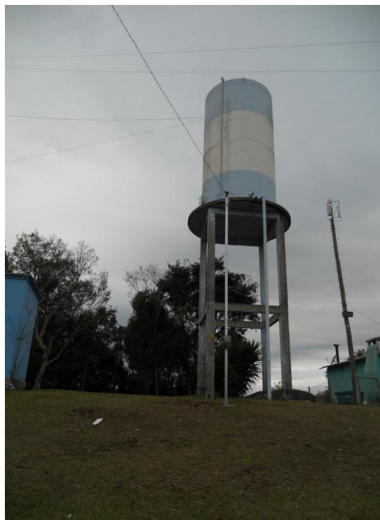
Figura 32 - Reservatório 05, 50m 3 , metálico, elevado, situado no Bairro Medianeira.
