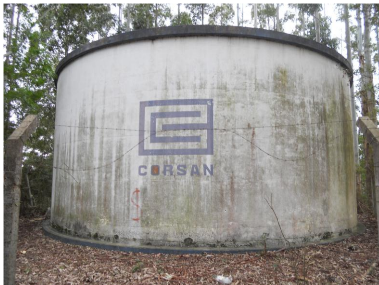
Figura 33 - Reservatório 06, 500m 3 , de concreto, apoiado, situado no Bairro Vera Cruz.
