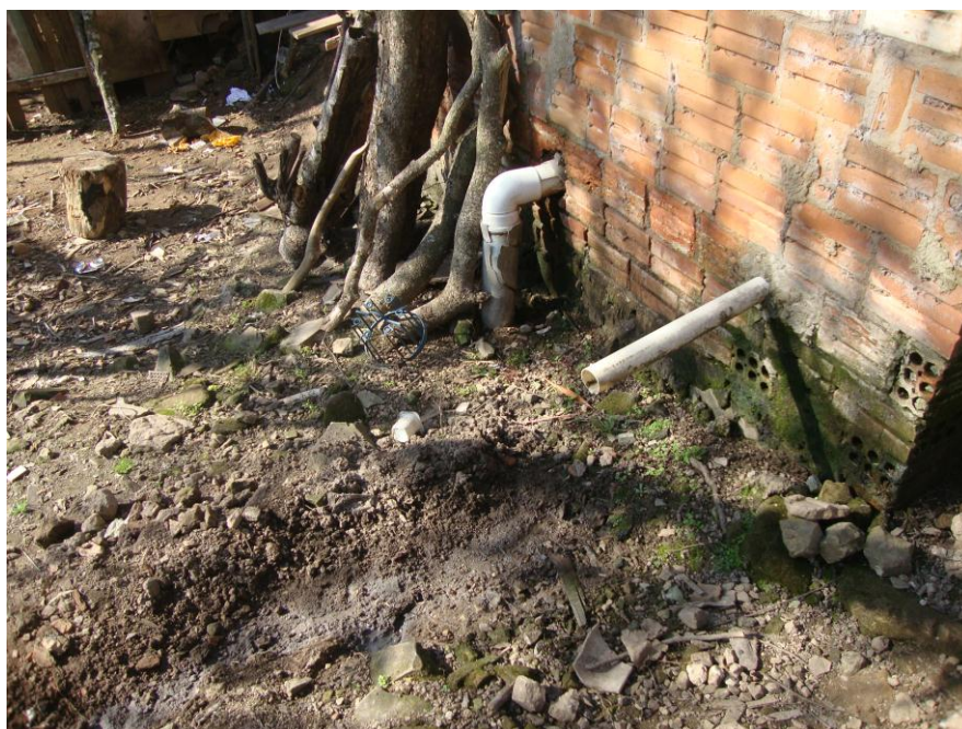
Figura 41 – Esgoto lançado a céu aberto
