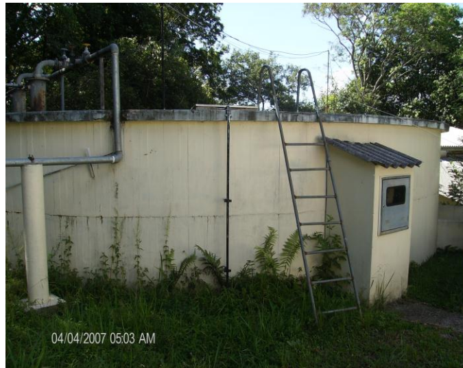
Figura 31 – Reservatório 04, 250m 3 , de concreto, apoiado, que está situado no pátio da ETA.
