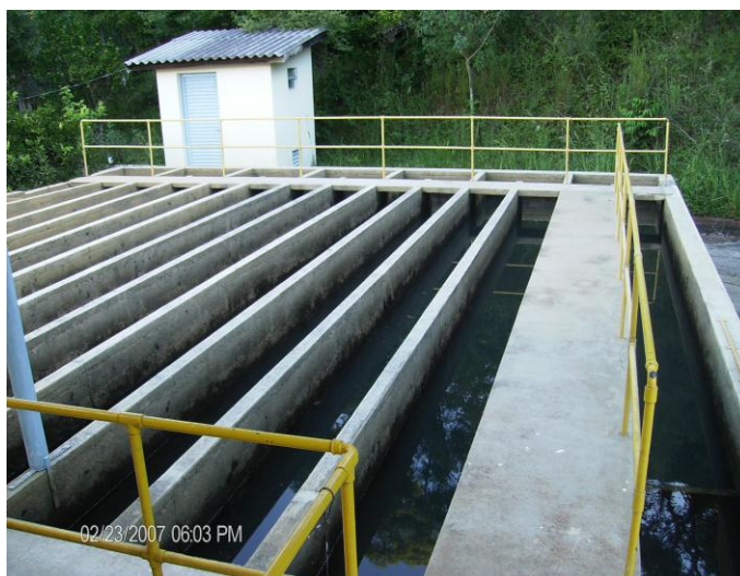
Figura 25 – Decantador da ETA
