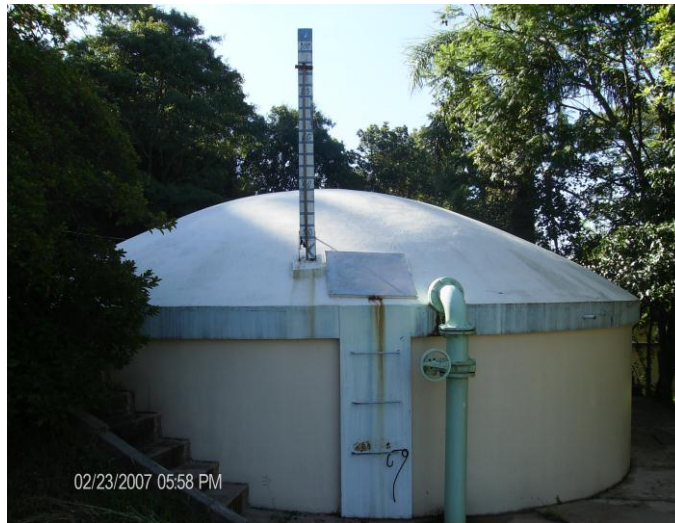
Figura 29 - Reservatório 02, 100m 3 , de concreto, apoiado, situado no pátio da CORSAN.
